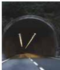
La sicurezza nei tunnel dipende anche da un impianto di illuminazione sempre efficiente: oltre alla manutenzione programmata, il sistema di telegestione permette di monitorare le prestazioni di impianto e confrontarle con gli standard di progetto.
